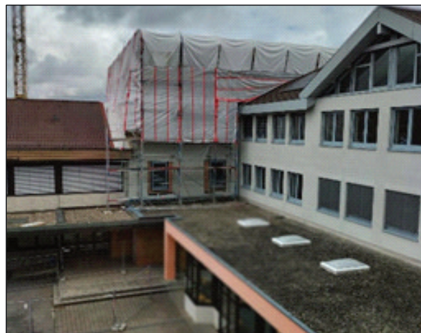
Schon von Weitem erkennen auch Schulfremde, dass hier Großes entsteht. Ein Teil des Gebäudes in der Steinachstraße ist mit Planen und einem Gerüstdach überdacht.
