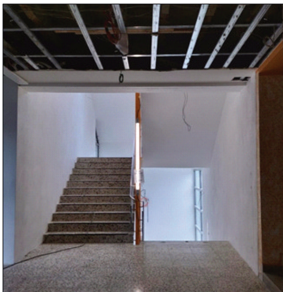
Das Haupttreppenhaus ist noch nicht ganz, aber doch schon fast – fertiggestellt. Die Gipsarbeiten sind abgeschlossen.
