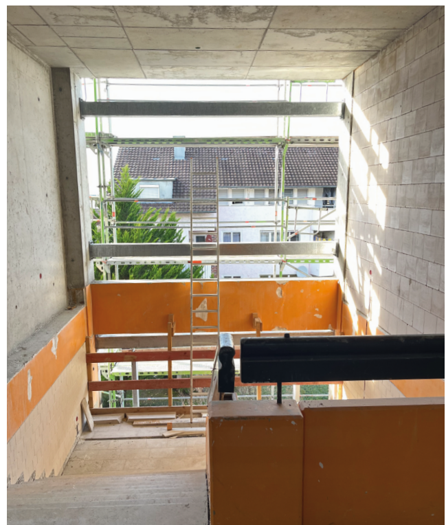
Sanierung des Treppenhauses. Bald wird es hier eine Glasfront und einen zusätzlichen Eingang mit Zugang von der Steinachstraße geben.
