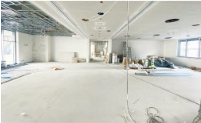
Die Sanierung schreitet voran
